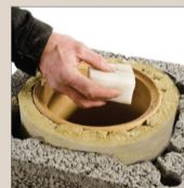
8. Oczyścić pióro-wpust wilgotną gąbką
