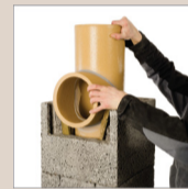
19. Osadzić kolejny element – podłączenie – trójnik ceramiczny
