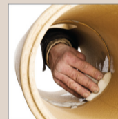
13. Usunąć nadmiar kitu z wewnętrznej strony fugi przy pomocy wilgotnej gąbki
