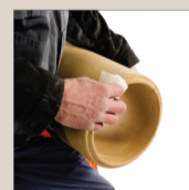
10. Oczyścić pióro-wpust wilgotną gąbką
