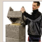
16. Założyć kolejny pustak z wyciętym otworem
