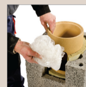
6. Do środka wyczystki włożyć kawałek folii lub papieru w celu ochrony przed spadającą zaprawą
