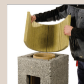
12. Nałożyć następny pustak oraz wełnę mineralną
