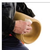
6. Oczyścić wilgotną gąbką każde łączenie przed nałożeniem kitu.
