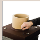
26. Płytę przykrywającą przykręcić śrubami z zestawu mocującego, założyć podkładki gumowe i metalowe, przykręcić nakrętkami kołpakowymi
