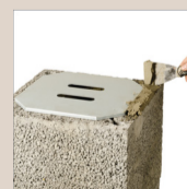
4. Nałożyć zaprawę korzystając z szablonu
