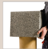
14. Osadzić kolejny pustak na zaprawie
