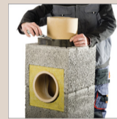
22. Przyciąć nadmiar wełny mineralnej
