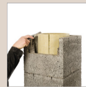
18. Dociać płytę z wełny mineralnej do rozmiarów otworu w pustaku
