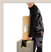
5. Umieścić pierwszy element ceramiczny – wyczystkę
