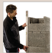
17. Dokładnie sprawdzać poziom kominu
