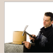
24. W otwory w narożnikach pustaka wbić dybłę do montażu płyty przykrywającej
