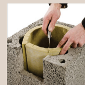
3. Dociać płytę z wełny mineralnej do rozmiarów otworu w pustaku
