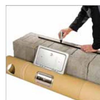
4. Kształtkę ceramiczną oczyścić, nałożyć kit kwasoodporny.
