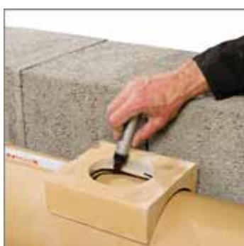
1. Ustalić żądaną wysokość podłączenia, odrysować wielkość otworu.
