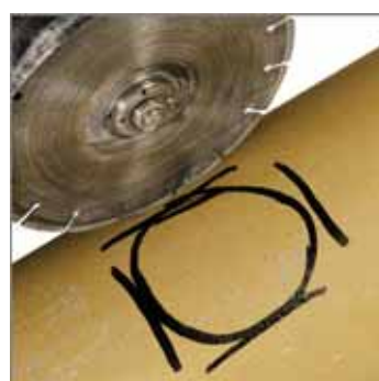
3. Szlifierką kątową wyciąć odrysowany otwór.
