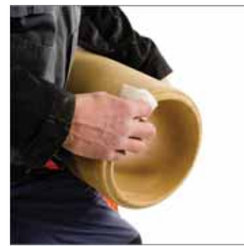
6. Oczyszczyć wilgotną gąbką każde łączenie przed nałożeniem kitu.
