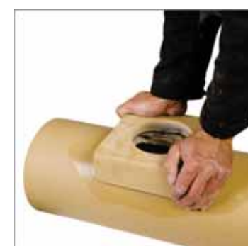
5. Mocno docisnąć kształtkę, pozostawić do wyschnięcia.
