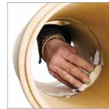
8. Nadmiar kitu zebrać wilgotną gąbką.
