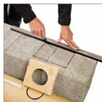
2. Zaznaczyć miejsce wycięcia otworu w pustaku.
