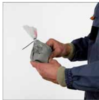
5. Połączyć składniki poprzez ugniatanie, po uzyskaniu jednolitej konsystencji pozostawić na 5 min.
