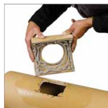
4. Kształtkę ceramiczną oczyścić, nałożyć kit kwasoodporny.
