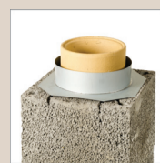
28. Umieścić szalunek trącony na ostatnim pustaku keramzytobetonowym
