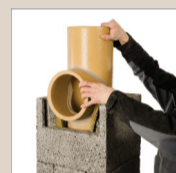
19. Osadzić kolejny element – podłączenie – trojnik ceramiczny
