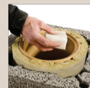
8. Oczyszczyć pióro-wpuszt wilgotną gąbką
