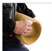
6. Oczyszczyć wilgotną gąbką każde połączenie przed nałożeniem kitu.
