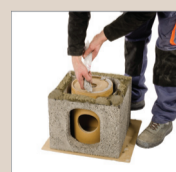
4. Oczyszczyć wilgotną gąbką miskę odpływu kondensatu i nałożyć kit kwasoodporny
