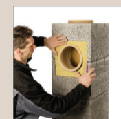
21. W wycięty w pustaku otwór wstawić płytę czołową z wełny mineralnej
