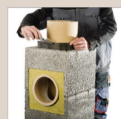
22. Przyciąć nadmiar wełny mineralnej
