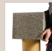
14. Osadzić kolejny pustak na zaprawie
