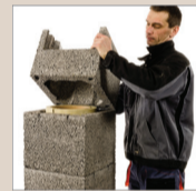
16. Założyć kolejny pustak z wyciętym otworem
