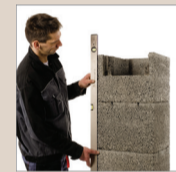
17. Dokładnie sprawdzić poziom kominu
