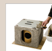
3. Nałożyć zaprawę korzystając z szablonu
