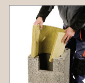
6. Włożyć wełnę mineralną w otwór pustaka
