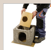
1. Na warstwę izolacji (np. folia budowlana lub papia) wkleić pustak z wyciętym otworem na odprowadzenie kondensatu, ustawić w nim rurę cokołową
