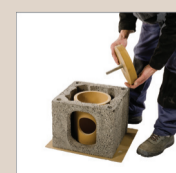
2. Połączyć miskę odpływu kondensatu i rurę cokołową kitem kwasoodpornym pamiętając o uprzednim oczyszczeniu powierzchni łączonych
